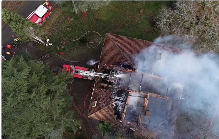
Un grave incendie détruit une maison
