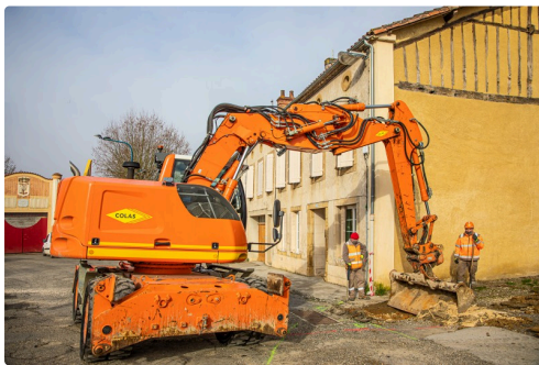
Travaux de terrassement aux arènes
