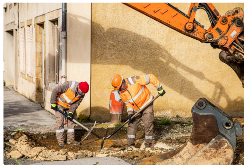
Les terrassiers continuent avec pic et pelle.
