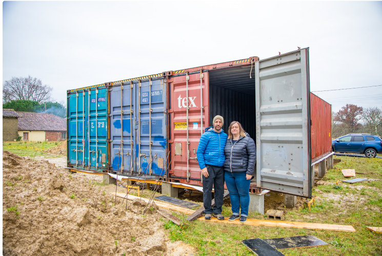
Un mécano moto bâtit sa maison en conteneurs maritimes (Lanne-Soubiran)
