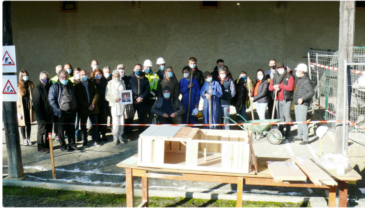
Lancement du chantier associatif des Sentiers de Villeneuve
