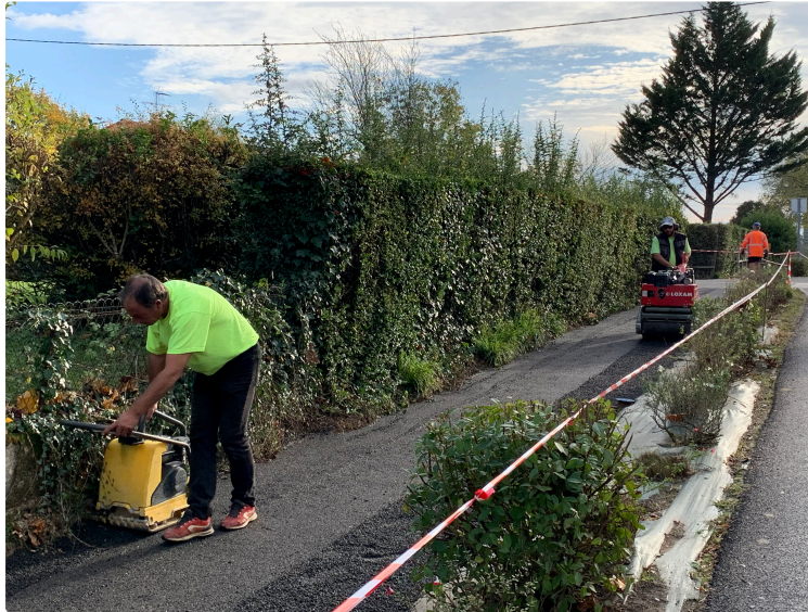
Rénovation de cheminement
