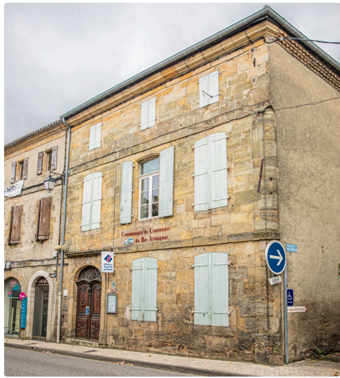
Les bureaux de la CCBA sont au 1er étage de ce bâtiment (77, rue Nationale)
