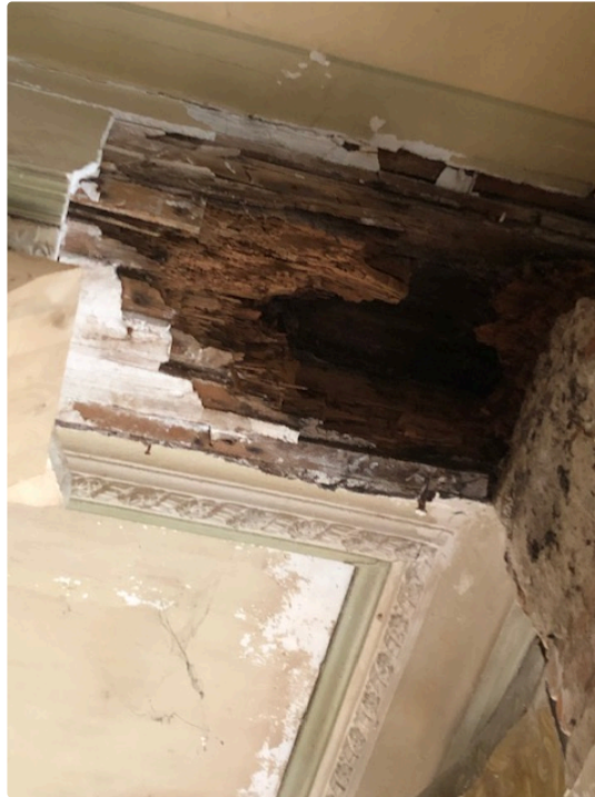
Mise à disposition d'un local pour l'opposition. (port du casque de chantier conseillé !)
