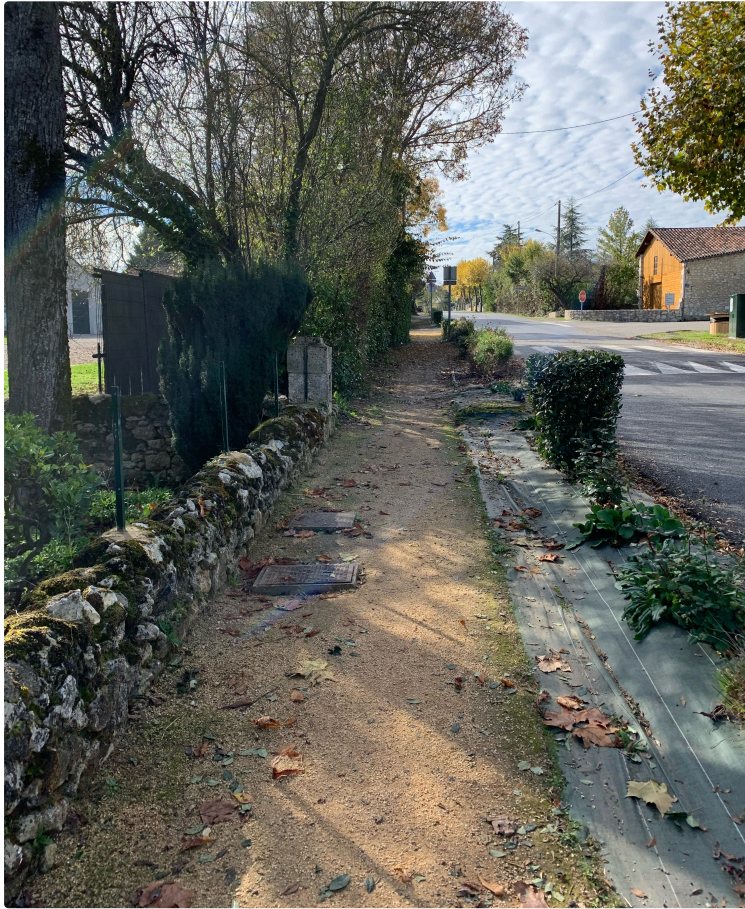
Des travaux sur le chemin piétonnier Avenue de Gascogne
