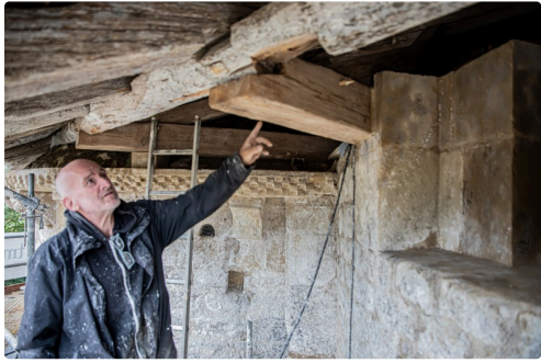
Cyrille Fourest montre la charpente rénovée
