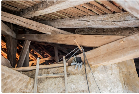
Aspect actuel de la charpente
