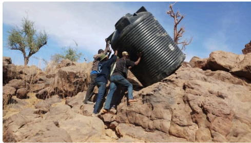
Mise en place d'un réservoir - Photo communiquée par Patrick Robert
