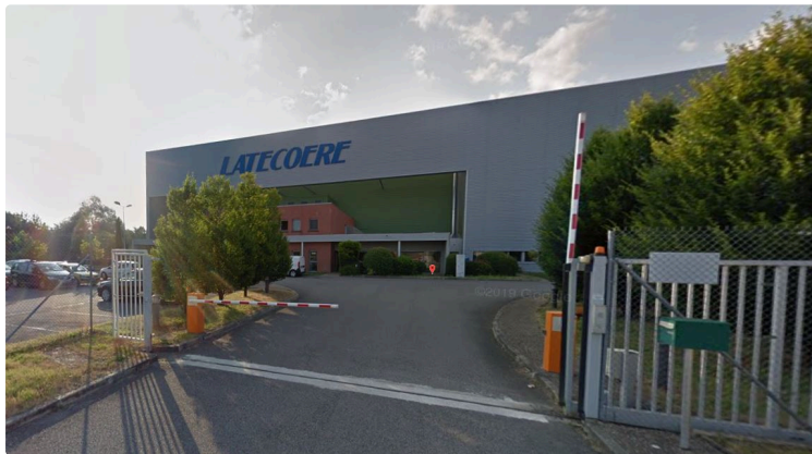
Latécoère : Coup de tonnerre dans le ciel gimontois
