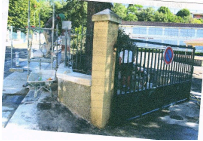
Les travaux d'été dans les écoles
