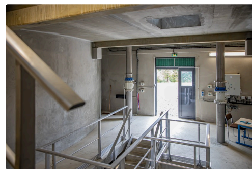
Intérieur du réservoir de Cannet entre les deux cuves jumelles
