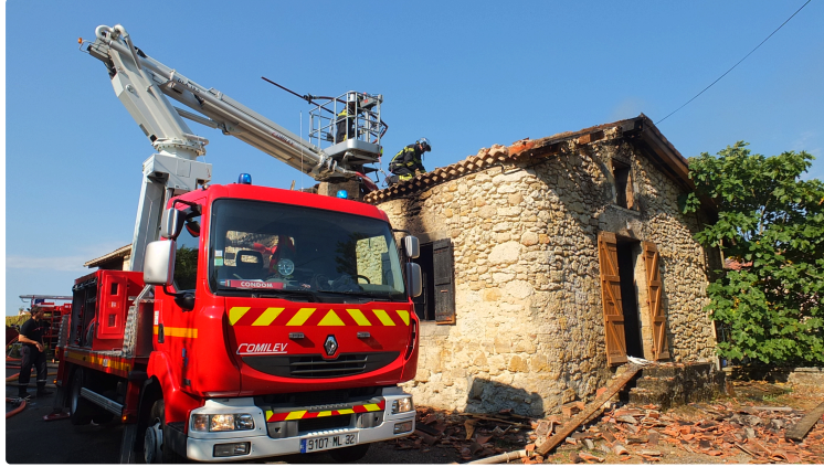
Une maison détruite par le feu
