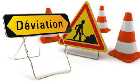
Réfection de la chaussée sur la RN 21
