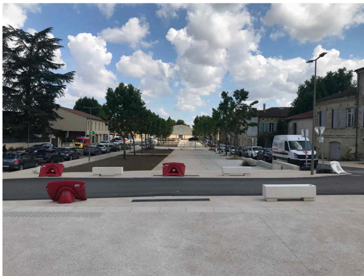
Travaux du Marcadet : dernière phase !
