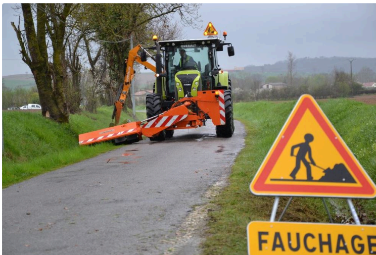
Reprise des travaux d'entretien des routes départementales
