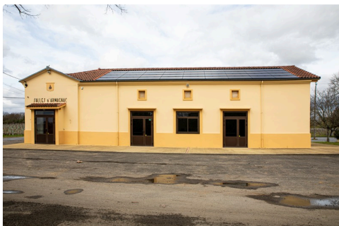
0 Mairie de salles-d'Armagnac 1bis 180320.jpg
