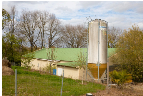
Le bâtiment d'élevage
