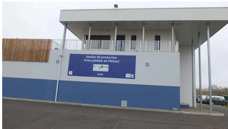
Trigone a présenté la toute neuve station de traitement des eaux
