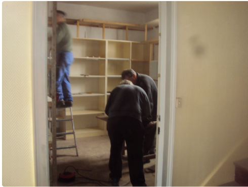
Les bénévoles ont quasiment achevé l'installation des étagères.
