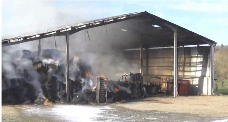
Un hangar agricole détruit par les flammes, deux hommes intoxiqués et six vaches légèrement brûlées
