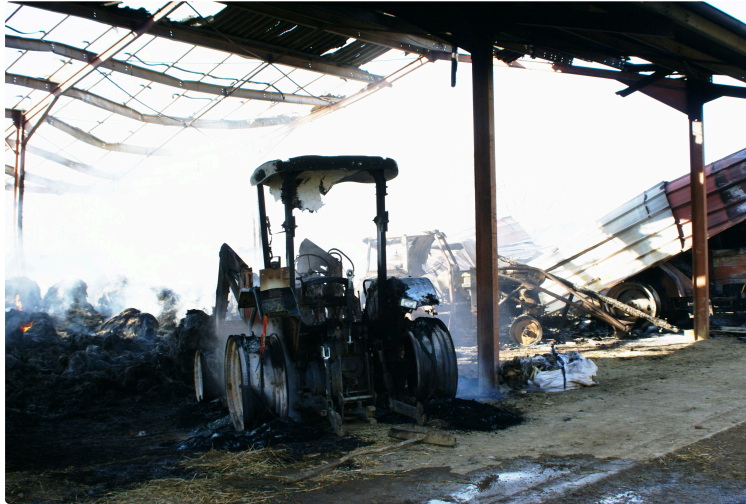
Un violent incendie détruit un hangar agricole
