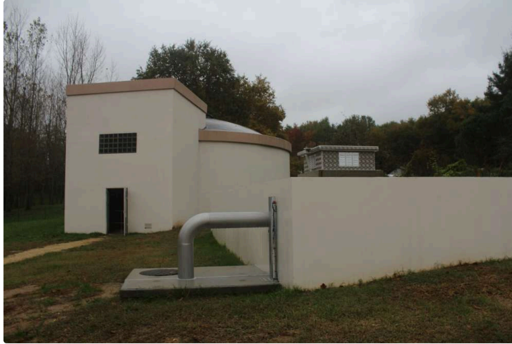
La nouvelle station de pompage a été inaugurée
