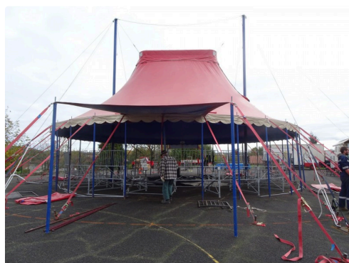
Le chapiteau de 250 places en cours de montage
