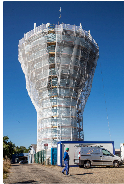
3 Le château d'eau sous échafaudage 1bis 111019.jpg
