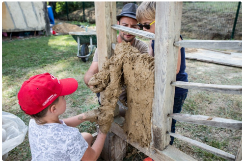
Les bâtisseurs au travail
