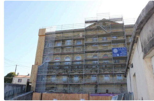
La façade Polignac, en travaux
