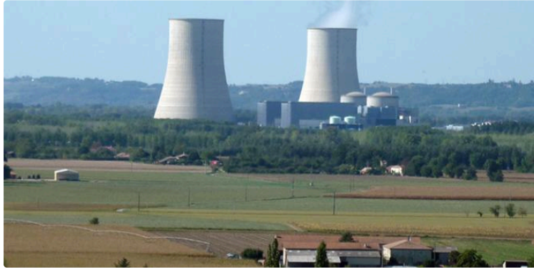
Distribution de comprimés d'iode stable autour de la centrale nucléaire de Golfech
