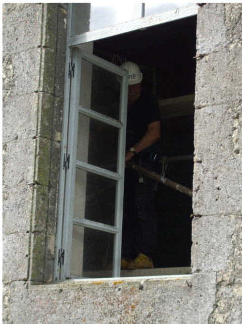
JMBey sur un échafaudage
