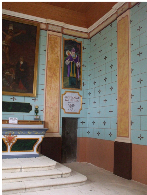
Plusieurs photos de la magnifique rénovation en cours
