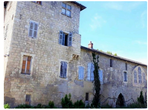
Juste à côté est prévu l'espace restauration
