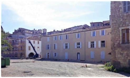
Une partie du site rénové
