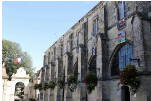
Panneau d'information coté sous-préfecture - Photos Marc Le Saux
