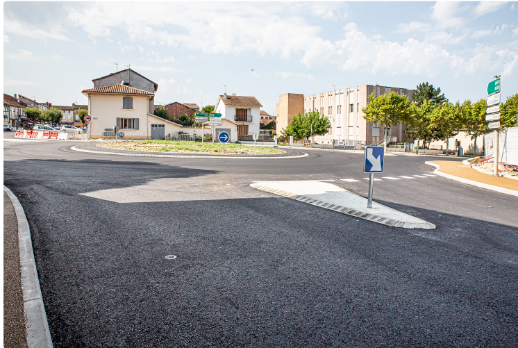
Le giratoire de l'hôpital de Nogaro est ouvert
