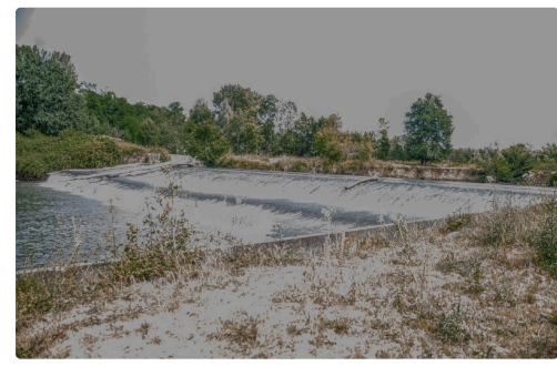
Vue du barrage des Charrutots...
