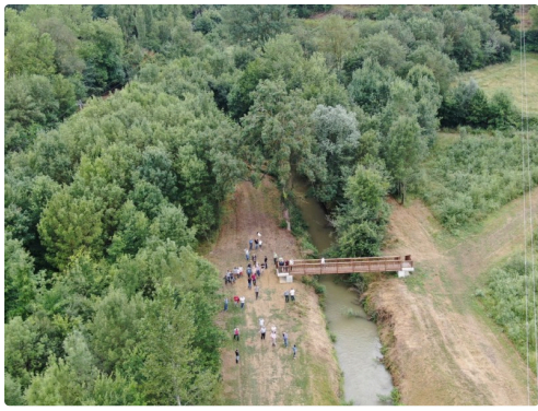
La passerelle vue du ciel...une intégration paysagère réussie
