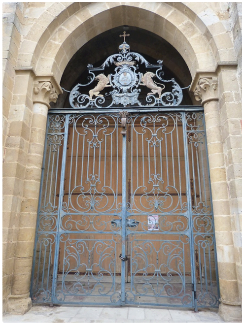
avant restauration photo année 2016
