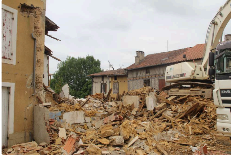
Les gros travaux ont commencé
