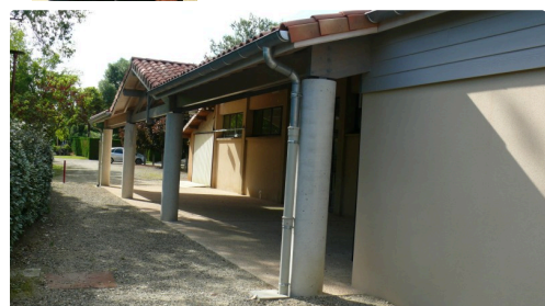
Agrandissement de la salle polyvalente par une couverture extérieure de 150 m 2 .
