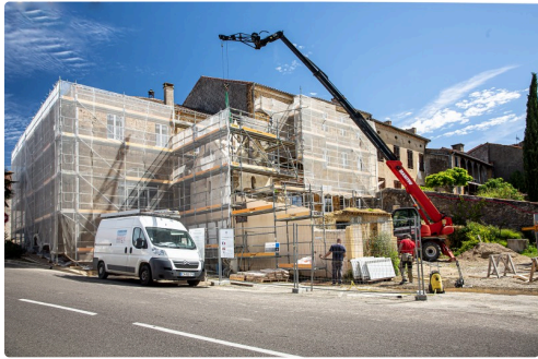
Le chantier vu du coin de la route d'Aire-sur-l'Adour
