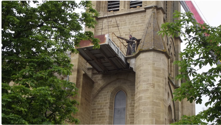
Poursuite des travaux à l'église
