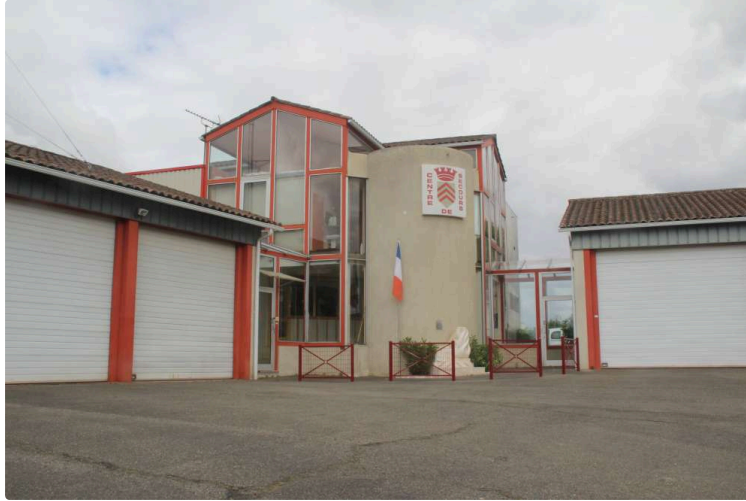
Les travaux au Centre de Secours s'élèveront à 200.000 euros
