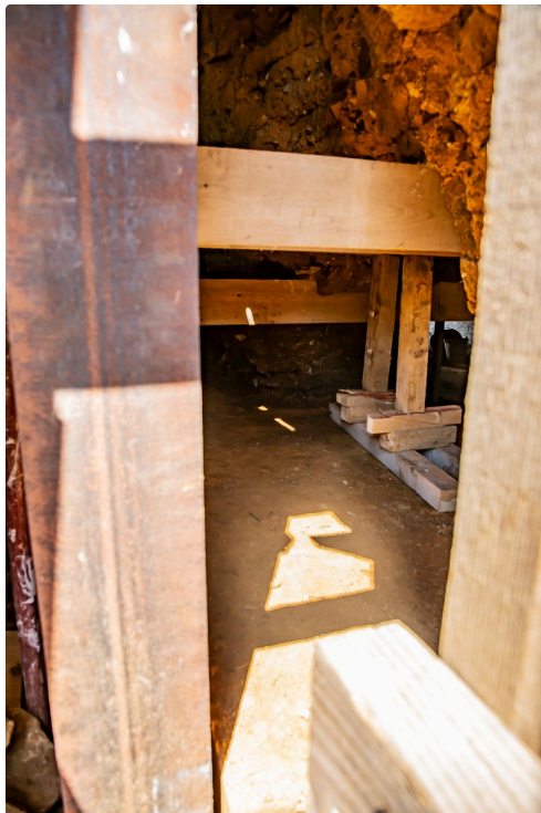
La cavité protégée à reboucher avec pisé et adobes
