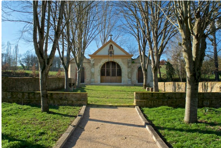
Quelques jours seulement pour terminer la toiture de la chapelle de Saintes ?
