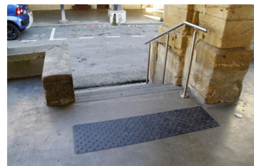
Accès à la mairie, marquage au sol et rampe d'escalier.
