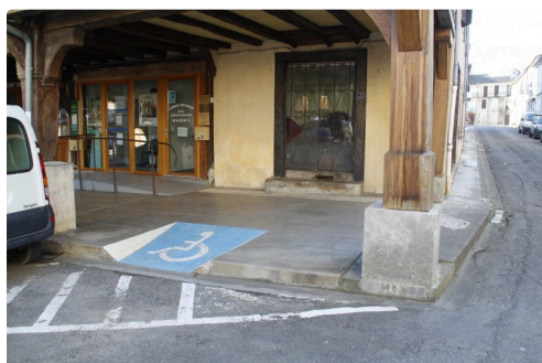
Rampe d'accès place de la mairie.
