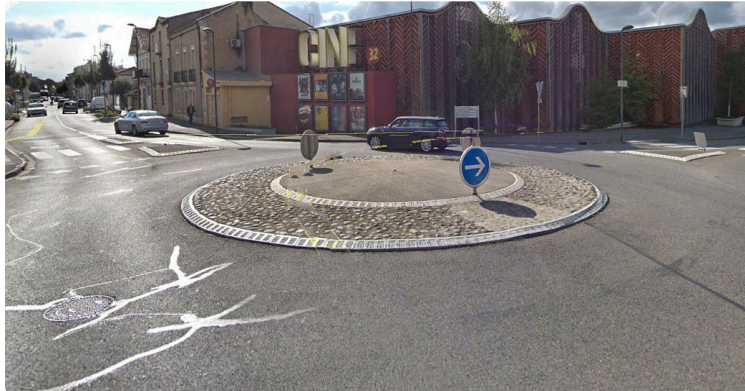
Travaux : circulation perturbée
