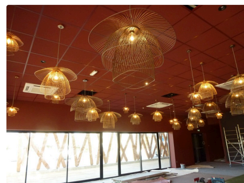
L'entreprise Ligardes peaufine les dernières installations électriques.
