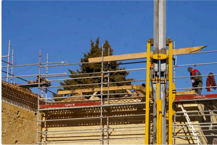
Église de Tasque en travaux de réhabilitation
