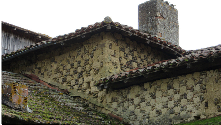
Les murs à damiers à la Une
