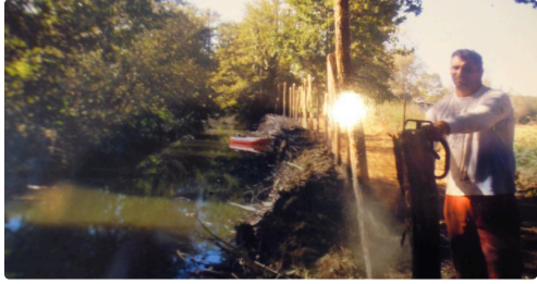
les travaux sur la berge du Boués
