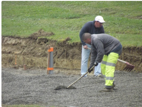
Le chantier pour la plate-forme
